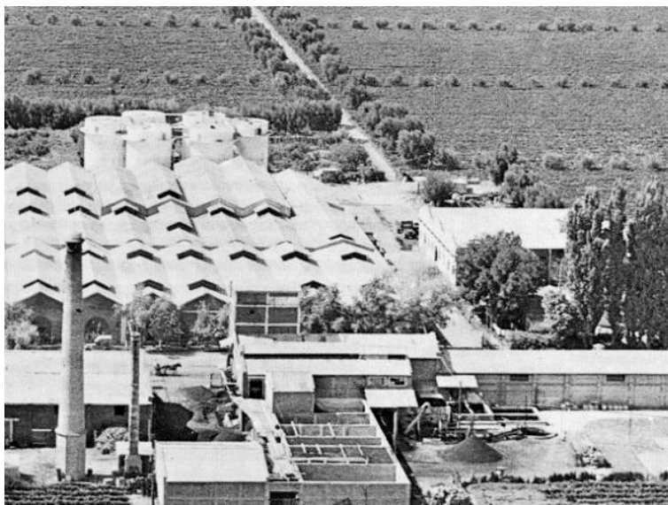
Vista aérea de las instalaciones de la empresa Gargantini en La Florida, Rivadavia. En el primer plano se encuentra la destilería de aguardientes con su chimenea. En segundo plano se ven los galpones que albergaban las cubas de roble. Detrás de ellos se encuentran las instalaciones para el sistema de fermentación continua, con forma de seis cilindros blancos. Más atrás, viñas y olivos. Fuente: foto circa, 1970.
